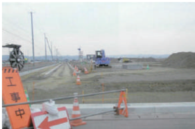
〈造成中の玉浦西団地（平成26年3月撮影）〉
